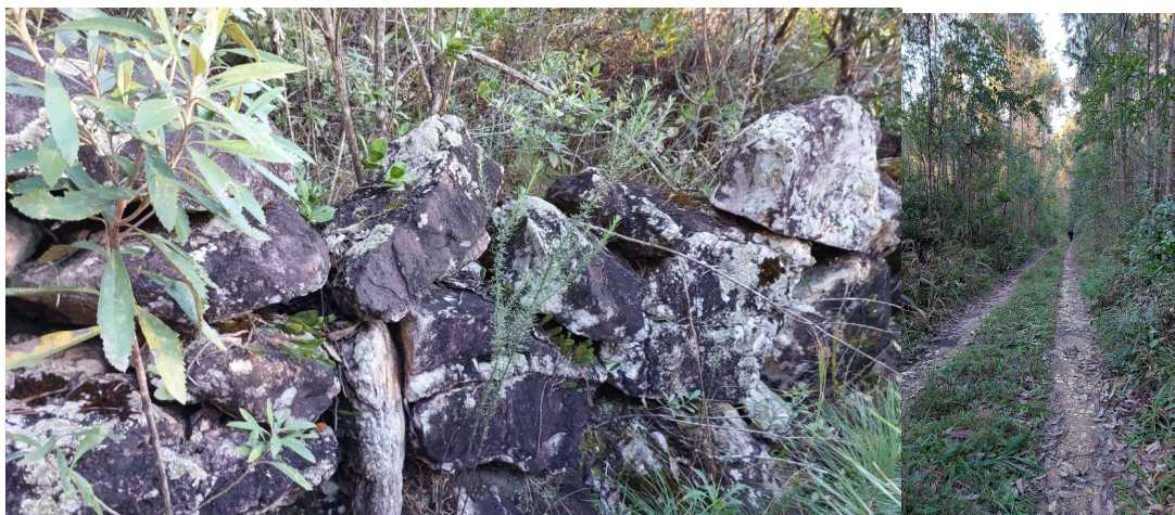
Muro de pedra e rua que dá acesso próximo ao local
