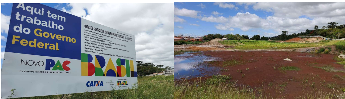
Bacias de contenção no Rio Palmital
